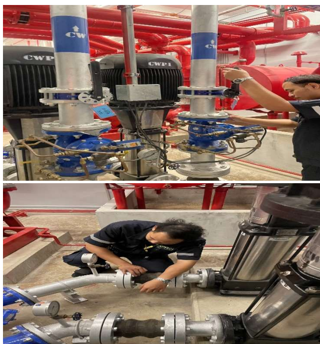
ภาคผนวกที่ 3.7 ตรวจสอบเครื่องสูบน้ำและวาล์วต่าง ๆ
