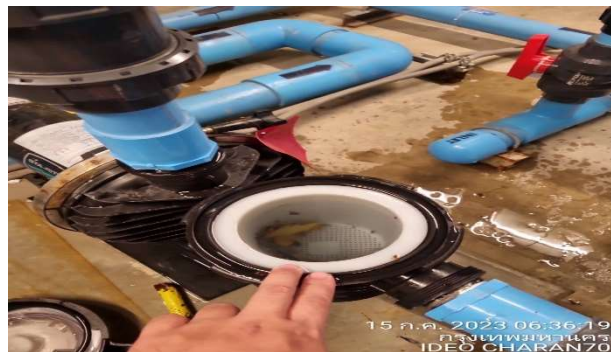
ภาคผนวกที่ 3.41 จัดให้มีเจ้าหน้าที่ตรวจสอบและความ ทำสะอาดระบบกรองสรวายน้ำ
